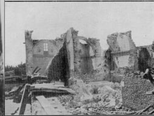
Fig. 33.—Restos de la iglesia de Acambay; conservación de los muros también apalillados N.-S. y del costado meridional del lado Norte y una parte del lado oriental sacados en una sola pieza hacia el Norte.
