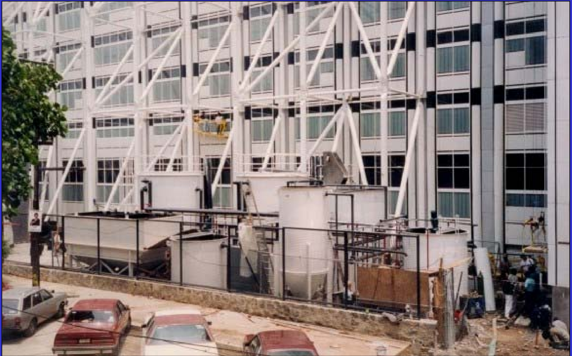
Hospital 20 de Noviembre, México. Reforzado. ✓✓✓✓✓✓✓✓
