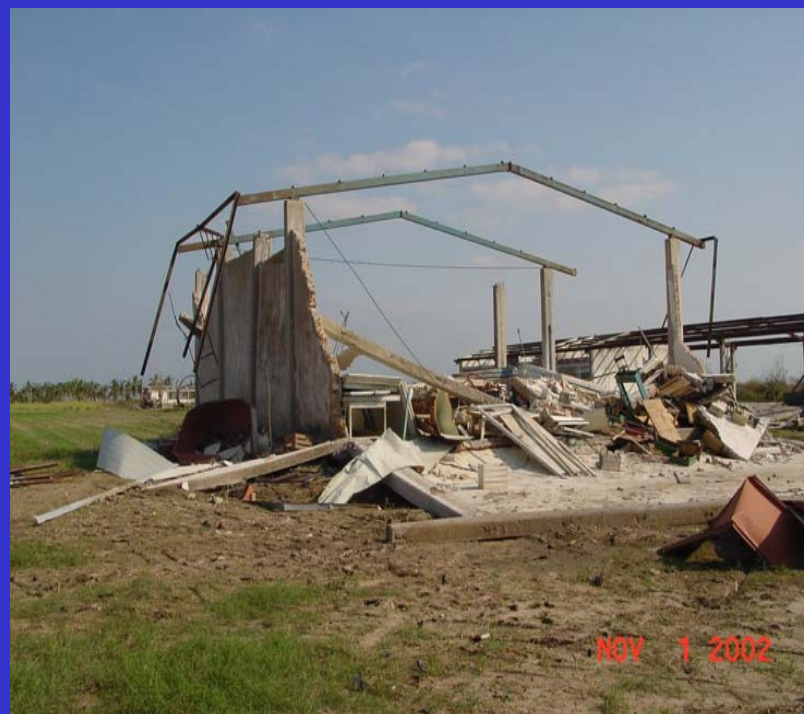
Escuela dañada en San Blas, Nayarit.
