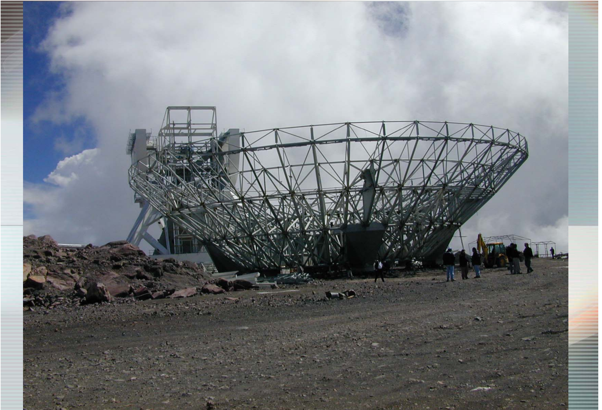
Estructura de la antena alineada en el suelo
