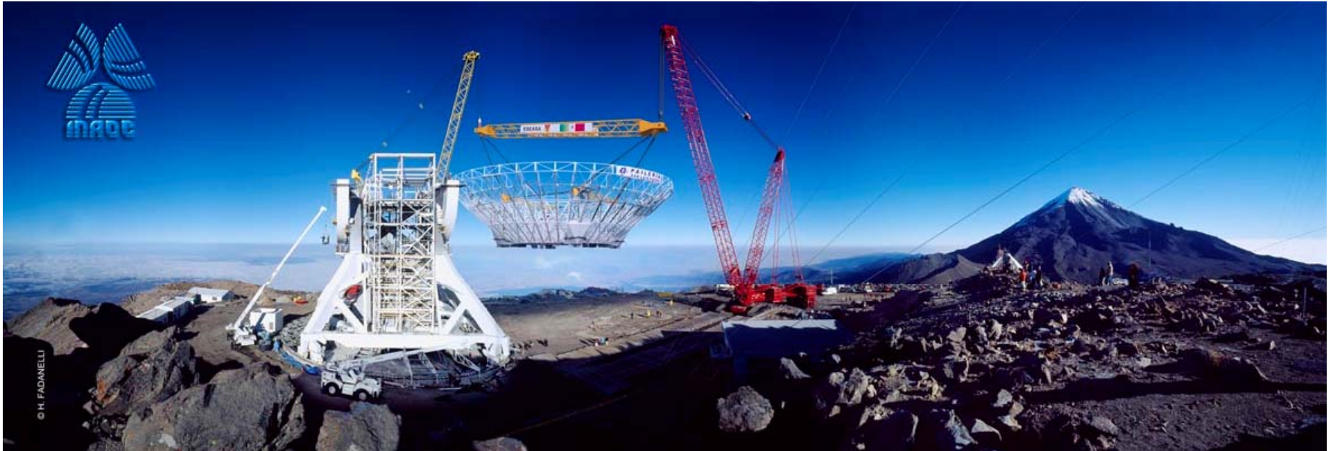
Levantando la estructura de la antenna en Noviembre, 2005
